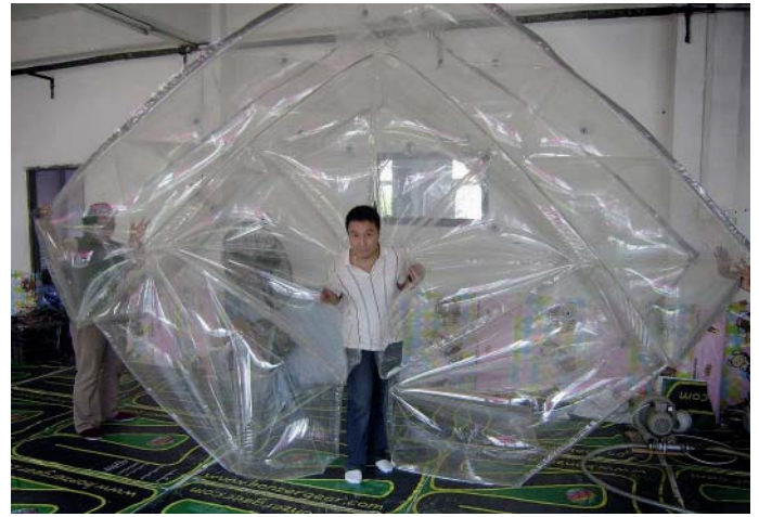
Die drei aus klaren Folien gefertigten Eingänge erhielten eine lamellenförmige Ausführung, sodass sich der Verlust von geheizter Luft aus dem Innenraum in Grenzen hält (Foto: pneumocell)
