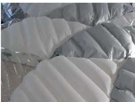
Genähte Verbindungen: Die sehr transluzenten Kissen im äußeren Bereich bestehen aus Fluorpolymer (PVDF)-Gewebe (Foto: Meisel GmbH)
